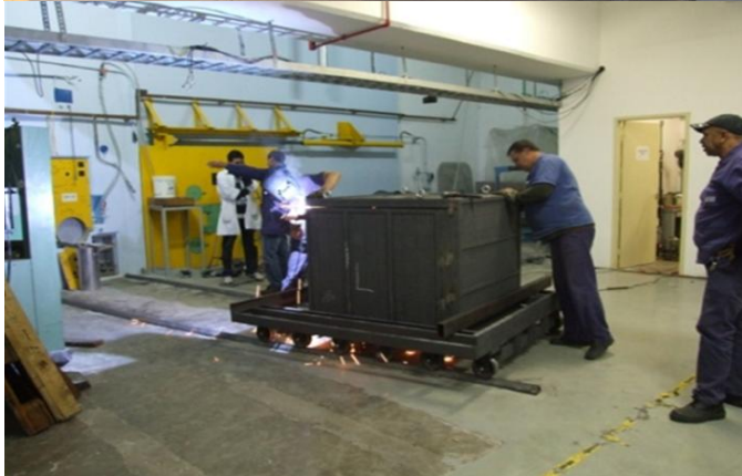
Figura 22. Montagem do beam-catcher nas oficinas do IPEN (cima), e a instalação da blindagem no BH nº14 do Reator Nuclear IEA-R1 (baixo).
